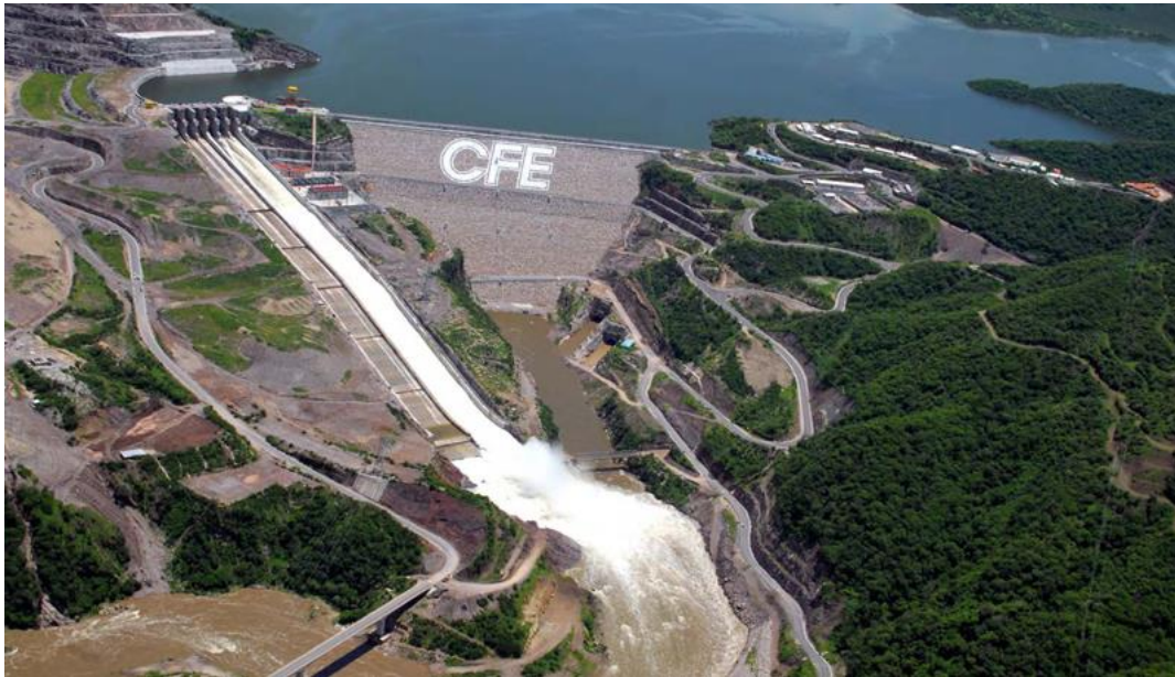
Energy and Commerce. (2021, enero). Hidroeléctrica [Fotografía]. Disponible en: https://energyandcommerce.com.mx/amlo-renovara-plantas-hidroelectricas-de-cfe/
